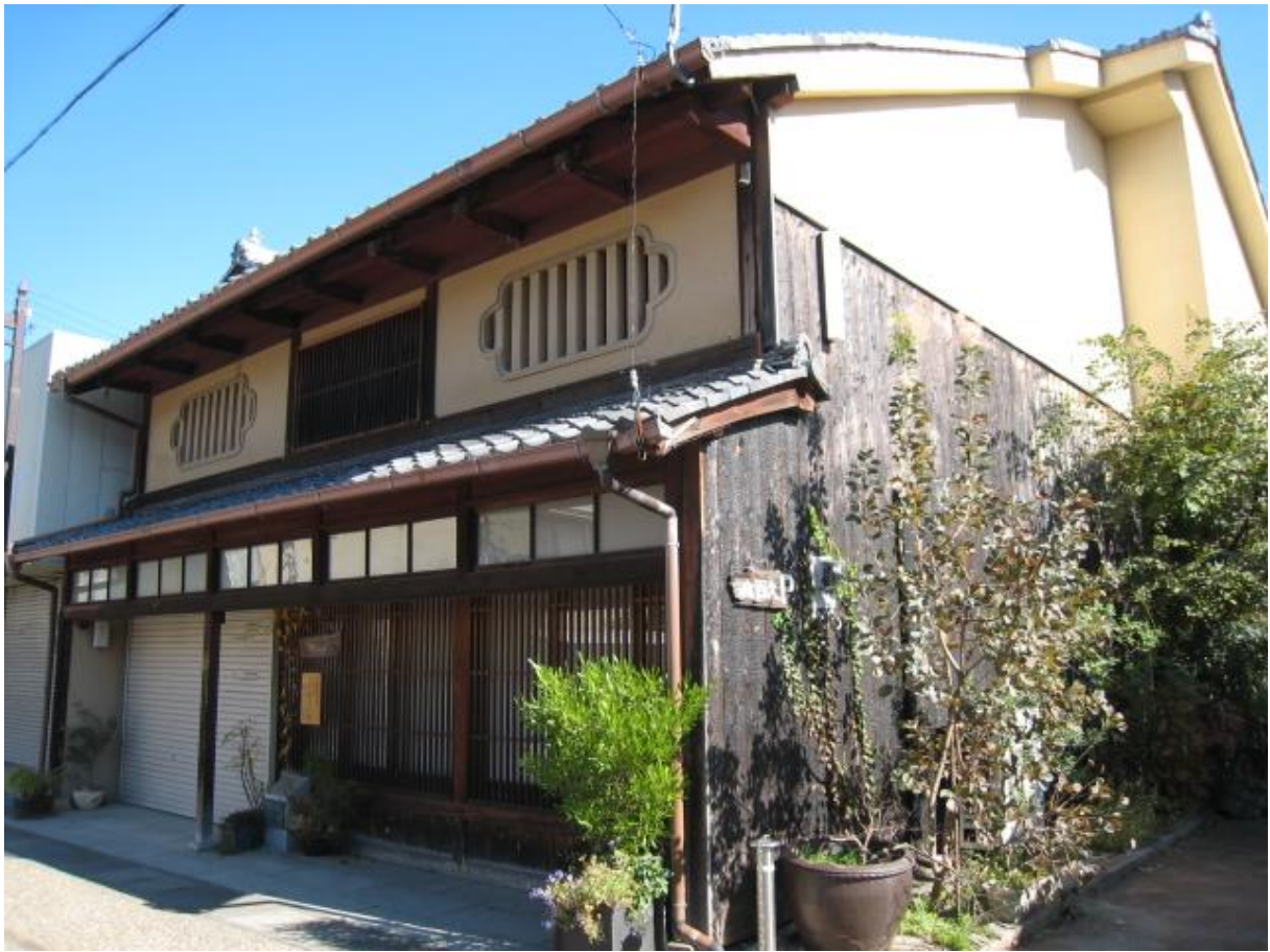
街道沿いの店舗（昭和3年の建築）格子窓と虫籠窓
