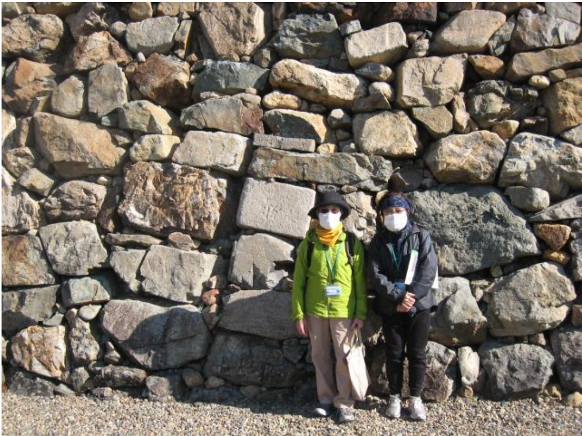
福知山城西面石垣前で（石垣の積み方→野面積み）石垣右側が光秀築城時の石垣？
