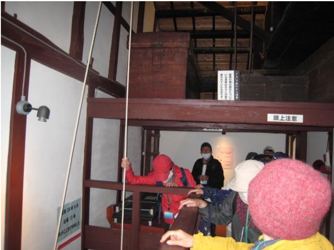
治水記念館内の洪水時、荷物を2階に揚げる仕組み
