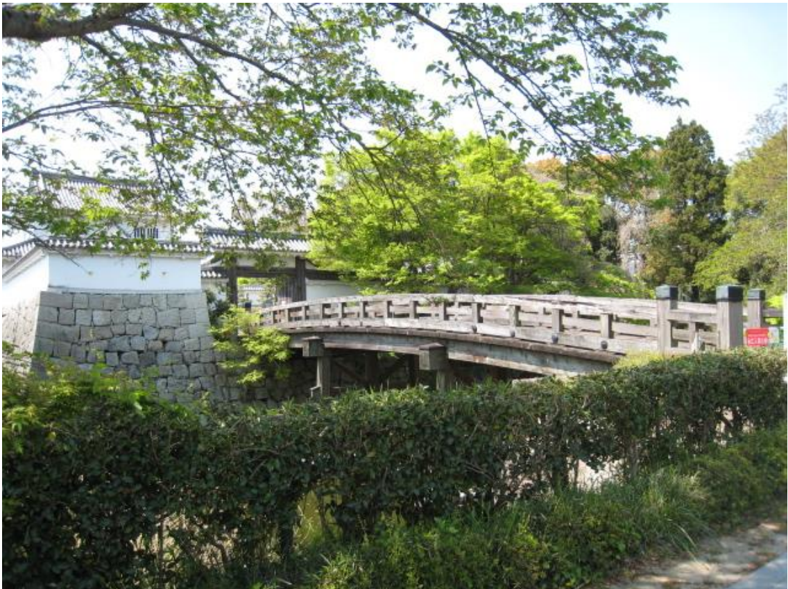
水口城跡の玄関橋（木造）左奥の建物は現在資料館として使われている。
