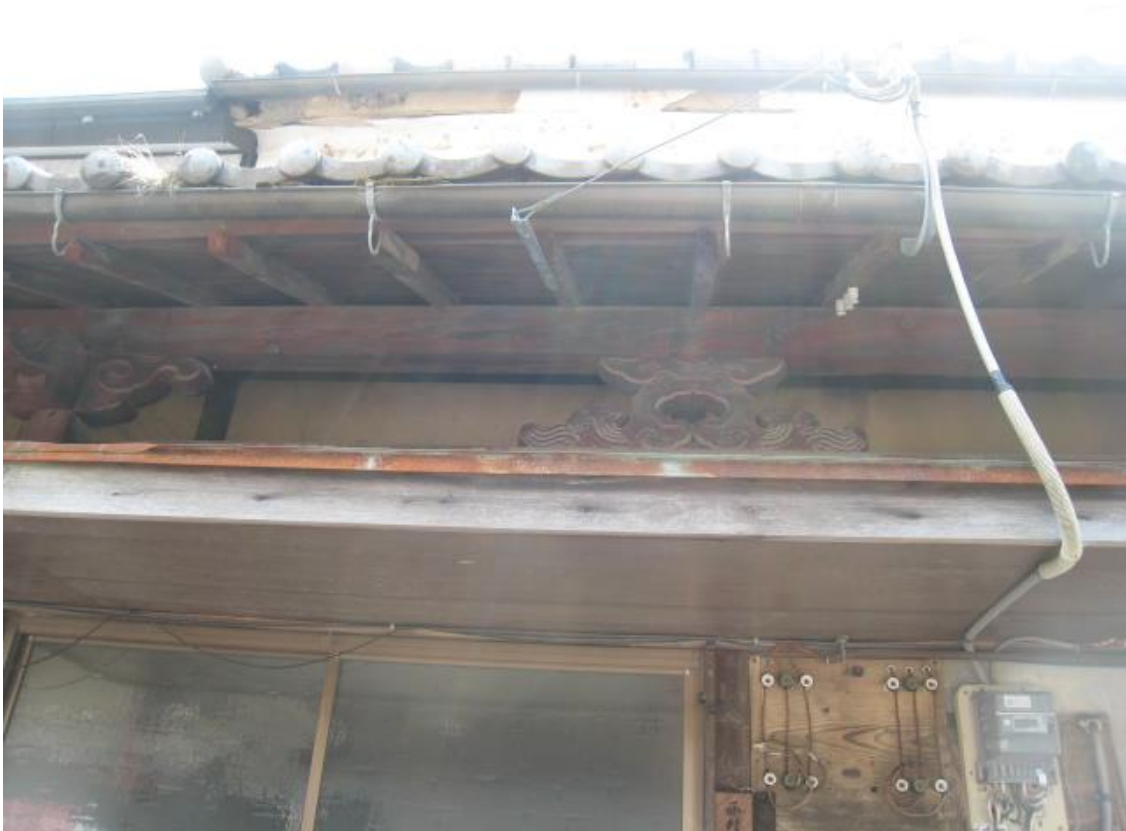
旧水口宿脇本陣の軒下の蓑股（彫刻されている蓑股）
