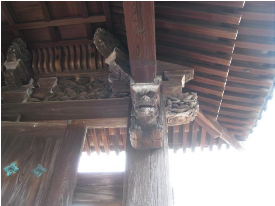
弘誓寺の門の軒裏の木組みと彫刻
