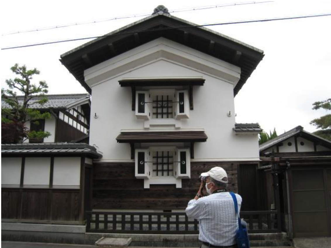
浮き屋根構造の蔵（屋根と壁の間に換気用の空間がある）
