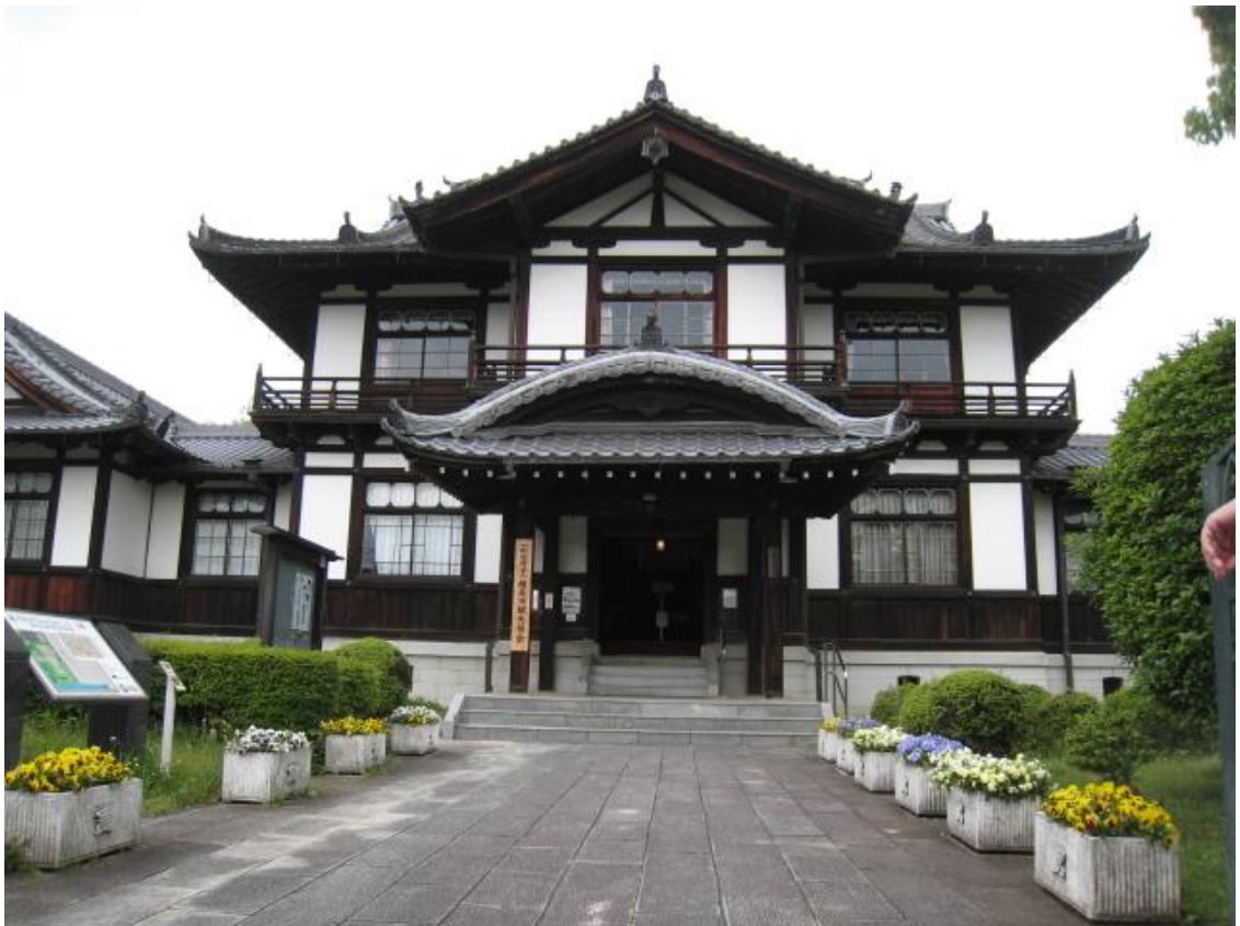
今井まちなみ交流センター（華薨）明治36年（1903）高市郡教育博物館として建設。
