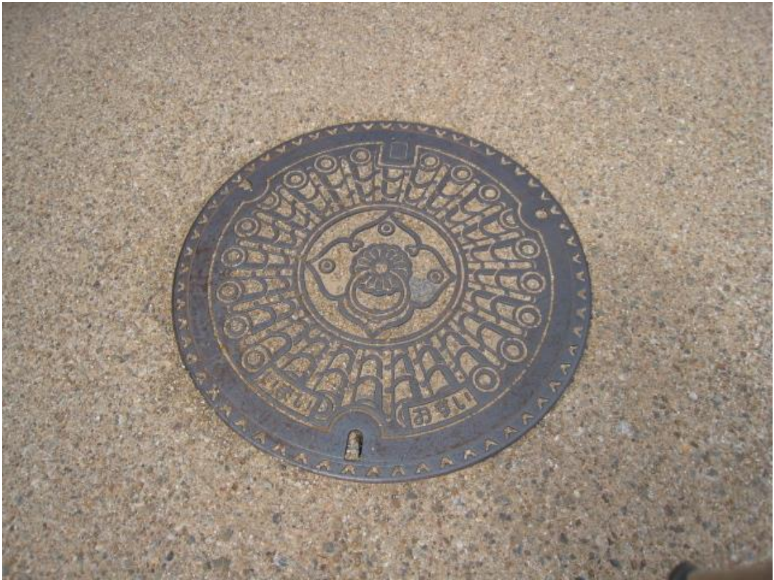
今井町内の下水マンホール
