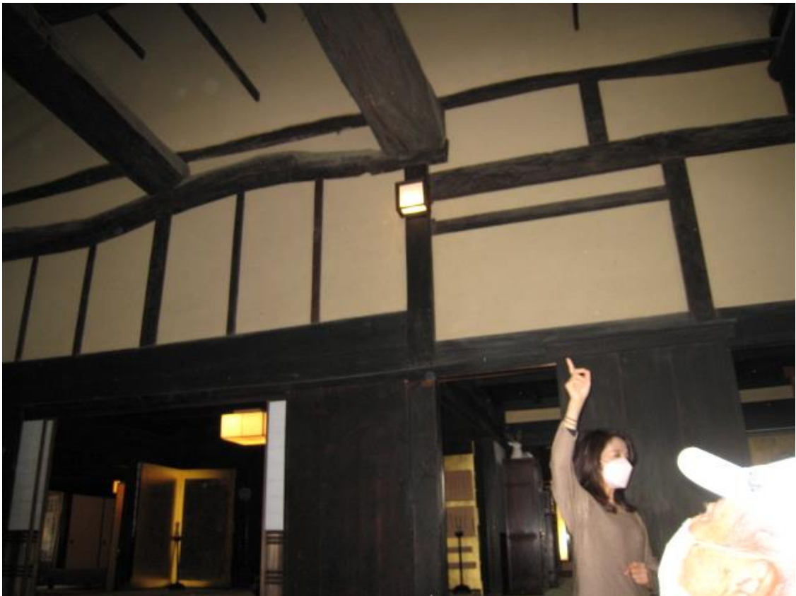
今西家の内部土間部分の天井構造（広い空間を支えるための工夫有り）
