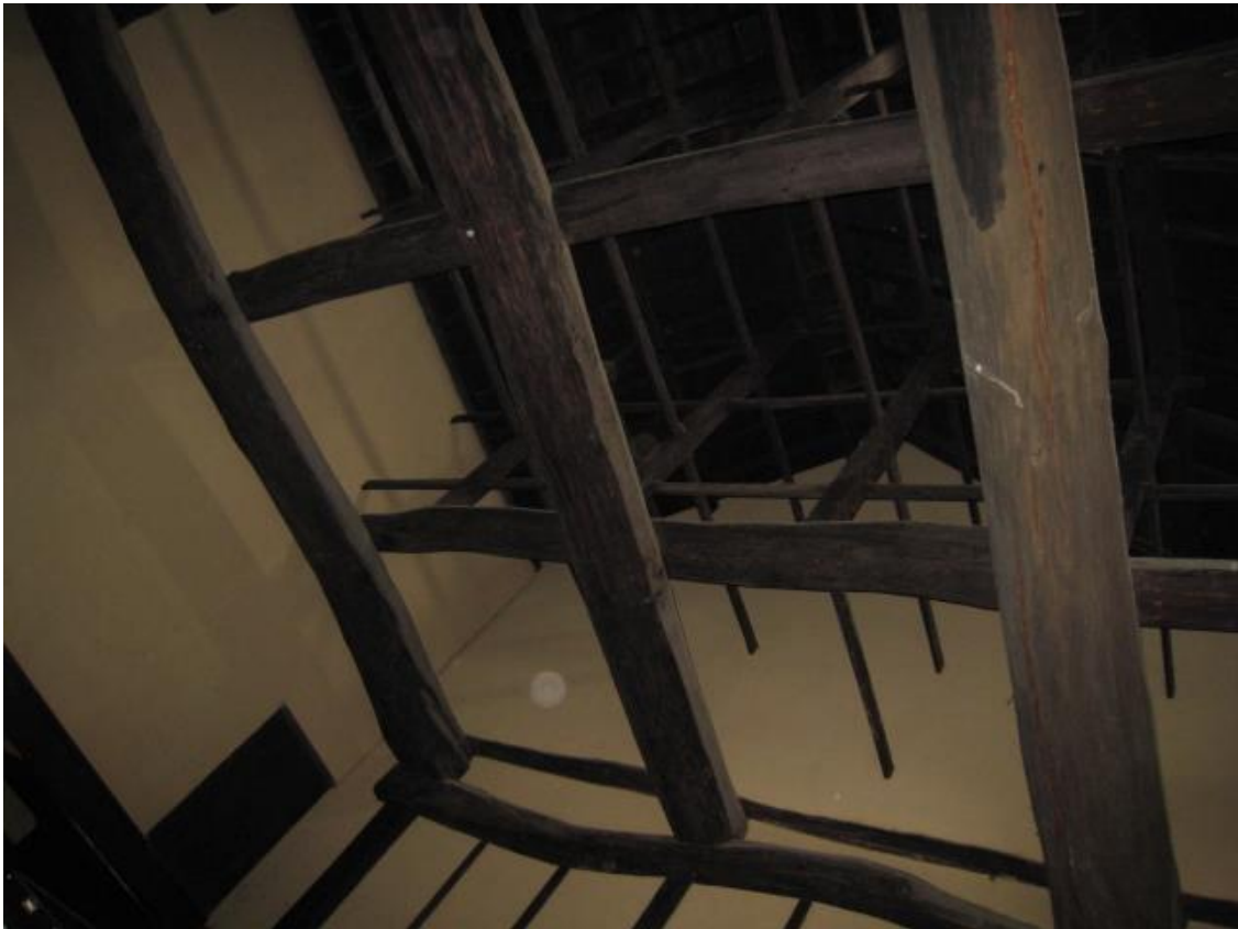
今西家の内部土間部分の天井構造（広い空間を支えるための工夫有り）
