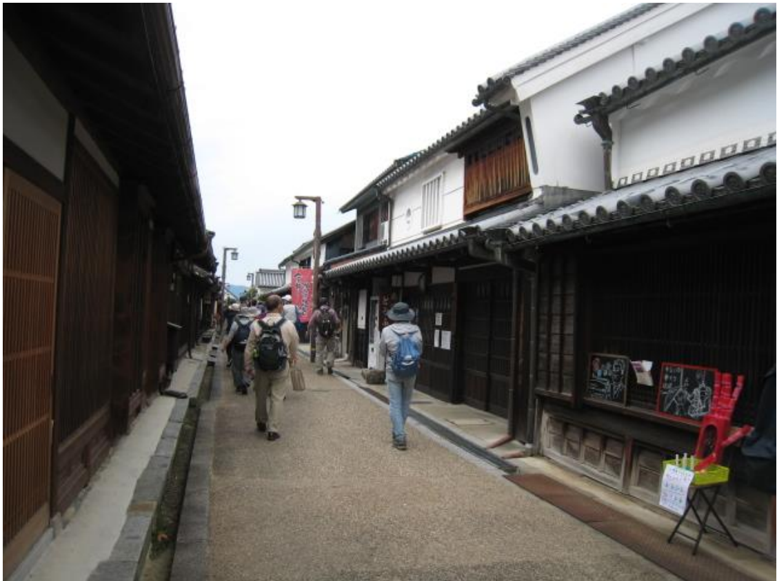
今井町のまちなみ（無電柱化されている）2階が高い建物は新しい建物
