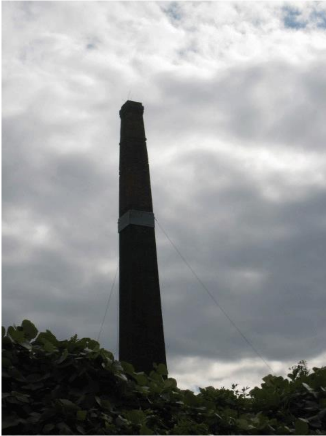
八幡堀遊覧船から見た煉瓦工場の煙突
