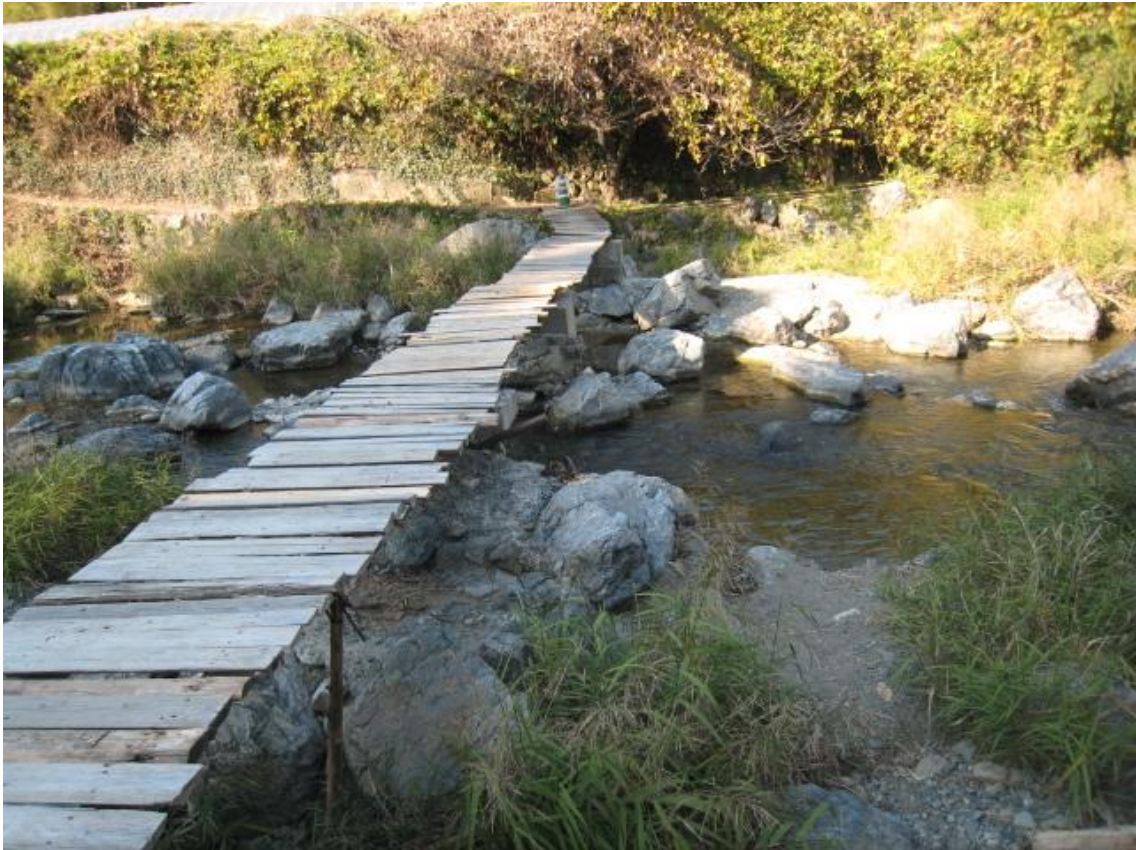
地元の人から危険だから渡らないようにと言われた芥川に架かる板橋
