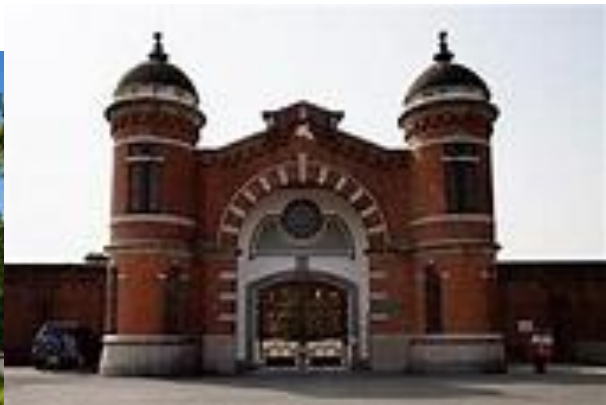
旧奈良少年刑務所 (ホテルに改修工事中)
